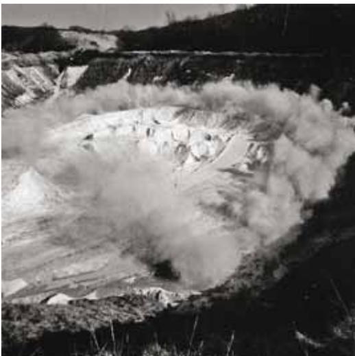
Mit Sprengschläuchen werden 1981 die 163 Stahltafeln der „Schlangenspur“ (WVZ 497) auf einen Schlag mit einer fortlaufenden Sinuskurve geformt.
