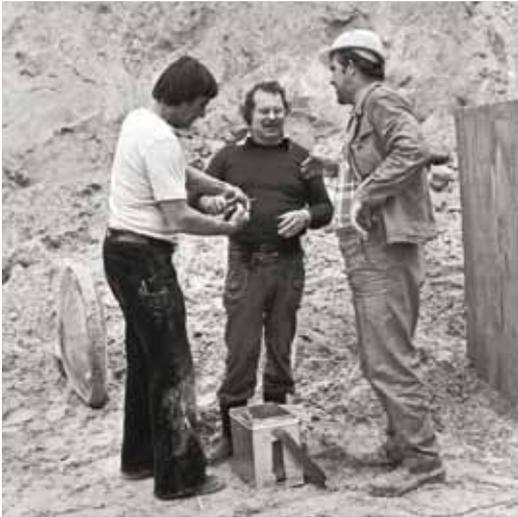
Friederich Werthmann (links) und erfahrene Sprengmeister bereiten eine Sprengung vor. Die an einem Holzstab befestigte Sprengladung wird in die Mitte gehalten und mit aufgefülltem Sand dort gehalten. Der Sand sorgt zudem für eine gleichmäßigere Kraftverteilung.
